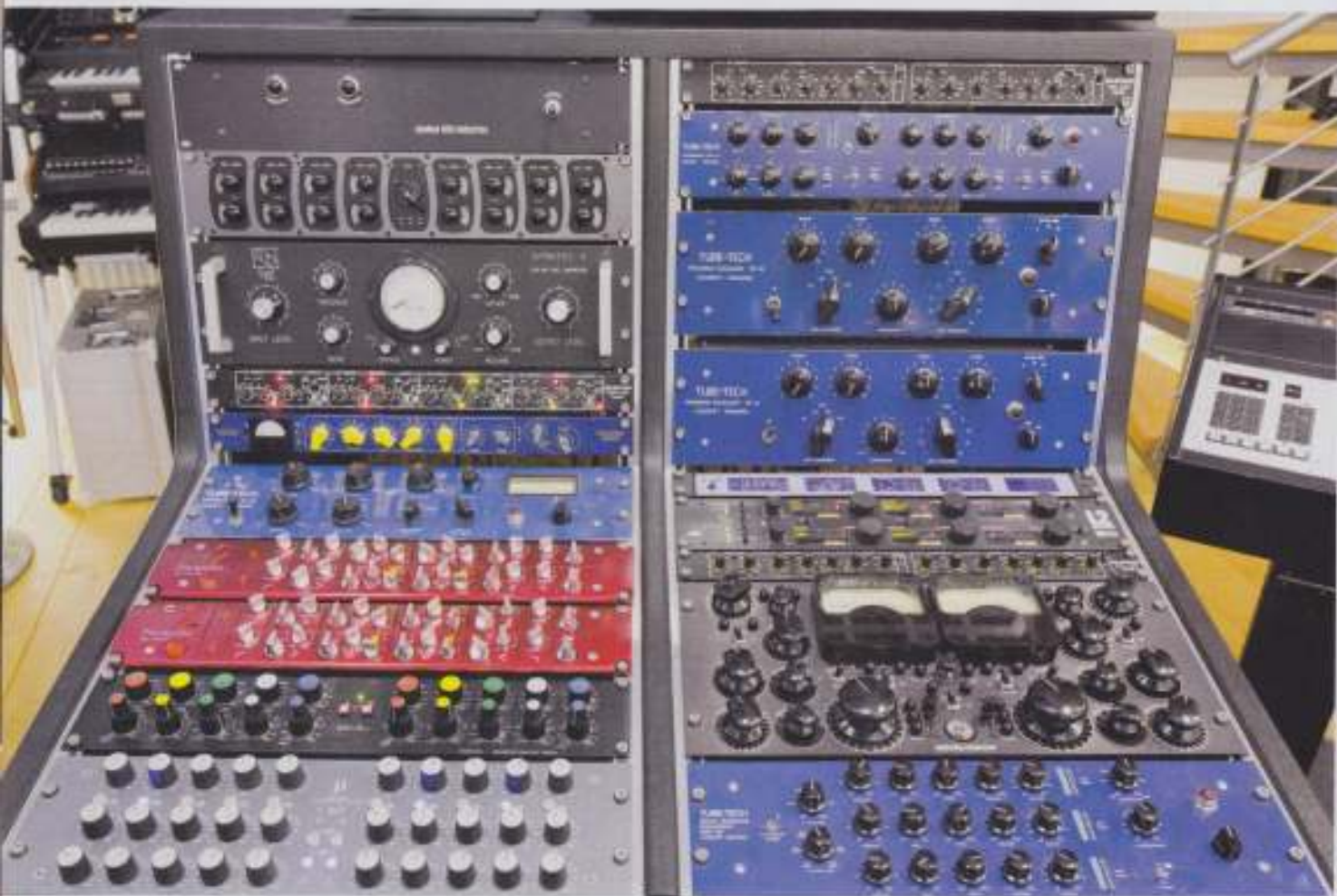
Das Mastering-Rack im Tonstudio Katzer in Nürnberg mit Equipment von Focusrite, Shadow Hills Industries und Tube-Tech
