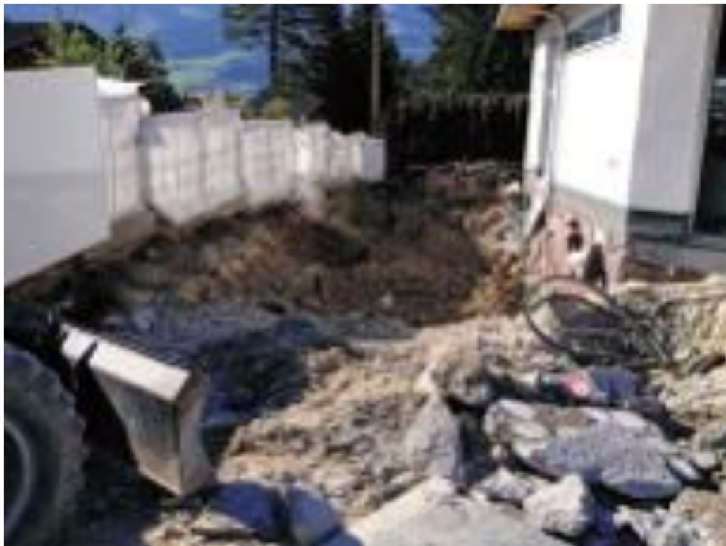
Erdaushub für Studio C...
